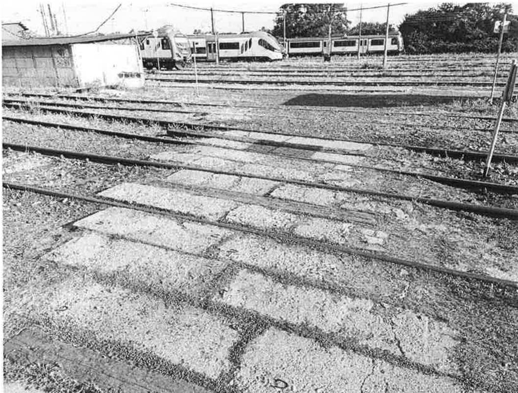
Zdj. 7 Nawierzchnia drogi dojścia w rejonie torów 203-204
