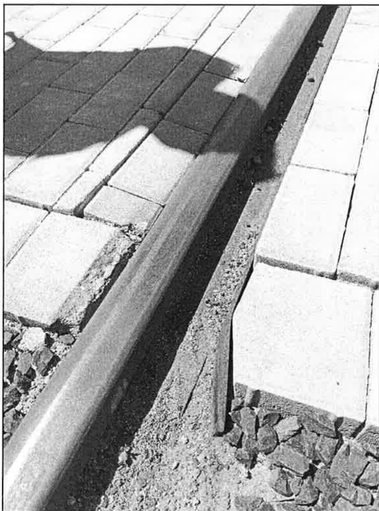
Zdj. 12 Przykład ogranicznika stalowego przy szynie
