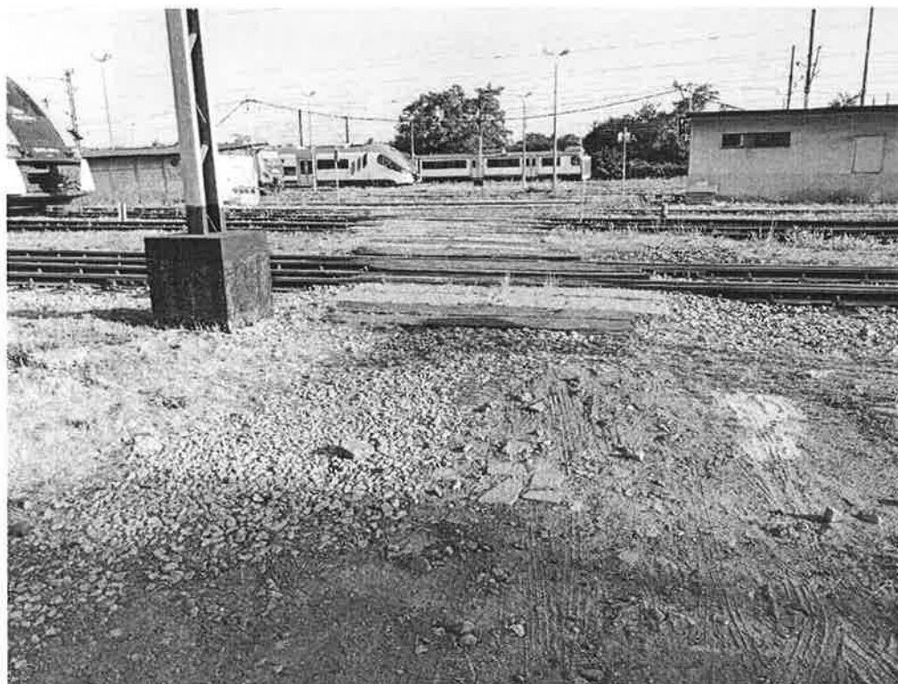
Zdj. 4 Istniejący, gruntowy fragment drogi dościa przy jezdni asfaltowej
