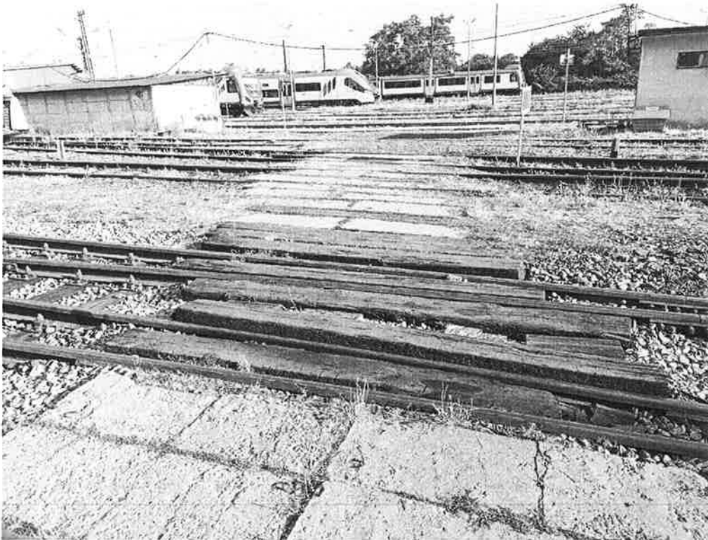
Zdj. 5 Nawierzchnia drogi dojścia w rejonie torów 201-202
